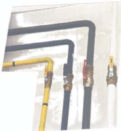
Demontažni spoji pri zapornih ventilih
