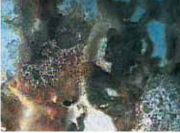
Korozyona uğramış fin yüzeyinin mikroskop görüntüsü.
