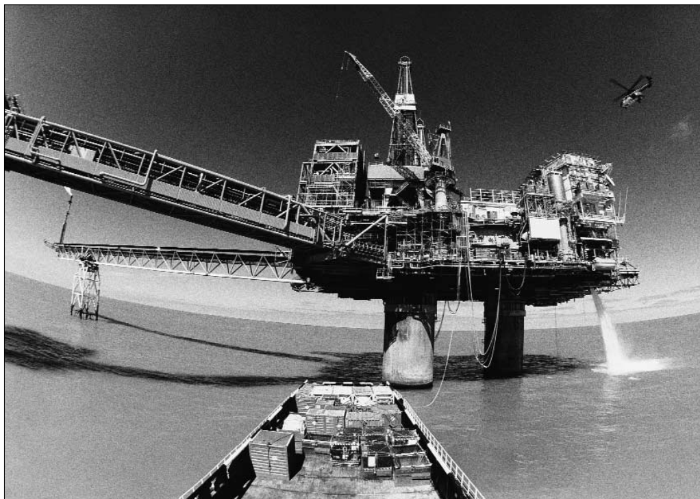
Einsatz von OZD FIP in der Petrochemie Application of OZD FIP in the petrochemical industry
